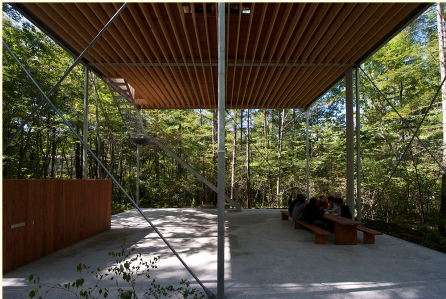
「森のピロティ」(群馬県吾妻郡) 設計は長谷川豪建築設計事務所の長谷川豪さん。完成は2010年。 鉄骨造と木造を組み合わせた特異な構造
